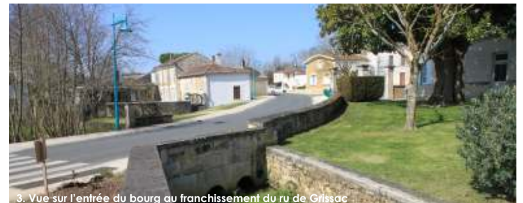
3. Vue sur l'entrée du bourg au franchissement du ru de Grissac
