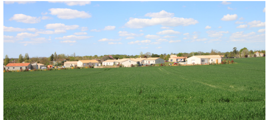
Nouvel ensemble résidentiel souffrant d'un manque d'intégration paysagère, du fait de la rencontre brutale entre espace agricole et constructions récentes
